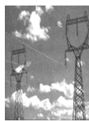
野外高压输电线上方有两条与大地相连的导线
